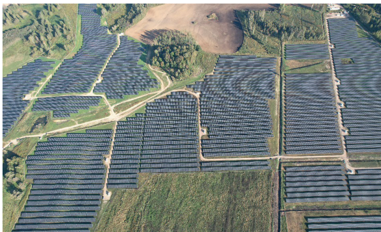
Solarpark mit einer Leistung von 73 MW, Konstruktionstyp: V3G2BI-15°, Lettland
