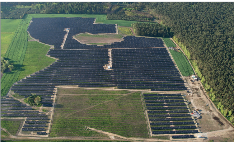
Solarpark mit einer Leistung von 18,5 MWp, Konstruktionstyp: W-V2G2-BI-25°, Woiwodschaft Lebus (Polen)
