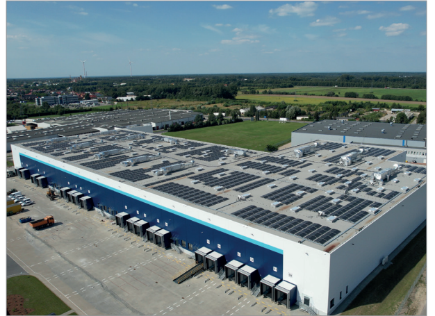
Anlage mit einer Leistung von 1 MWp, Konstruktionstyp: DP-DNHBE-WZ-10°, Woiwodschaft Masowien (Polen)
