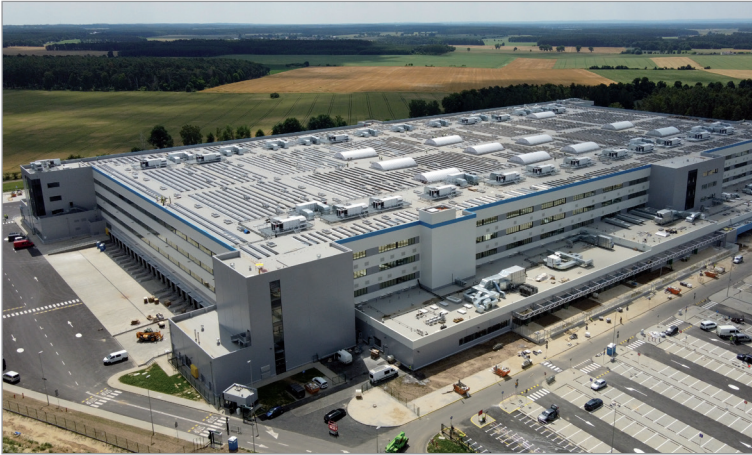
Anlage mit einer Leistung von 1,8 MWp, Konstruktionstyp: DP-DNHBE-15°, DP-DNHWE-15°, Woiwodschaft Lebus (Polen)
