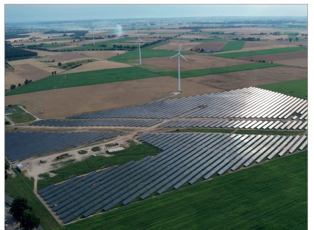
Solarpark mit einer Leistung von 1 MWp, Konstruktionstyp: DP-DNHBE-WZ-10°, Woiwodschaft Masowien (Polen)
