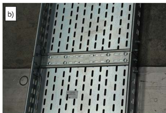
Zdjęcia 12: Analiza częstotliwości konstrukcji długich: a) Test 2a, b) Połączenie pomiędzy korytkami kablowymi
